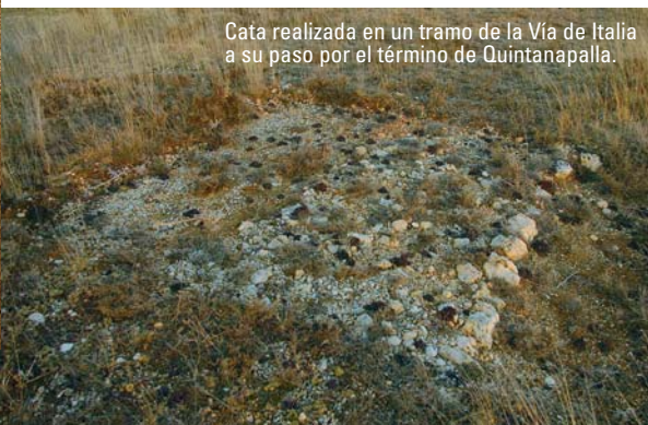
En contra de lo que se cree habitualmente, las calzadas no estaban entosadas en superficie: presentaban una capa de rodadura lisa de materiales finos, con anchura suficiente para facilitar el cruce de dos carros y con el menor número de curvas. Para evitar los efectos erosivos del agua, estaban bien drenadas y se elevaban sobre el terreno mediante la construcción de terraplenes.
